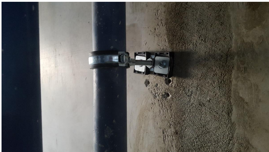
Infästning med specialklammer med dämpning på rör och vid bjälklag.
