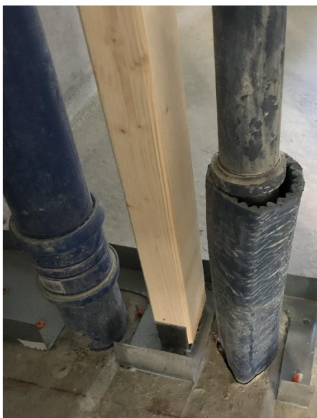
Figur 2 - Fristående regel som vakuurrör från toalett (svart) ska fästas mot med specialklammer med vibrationsdämpning.
