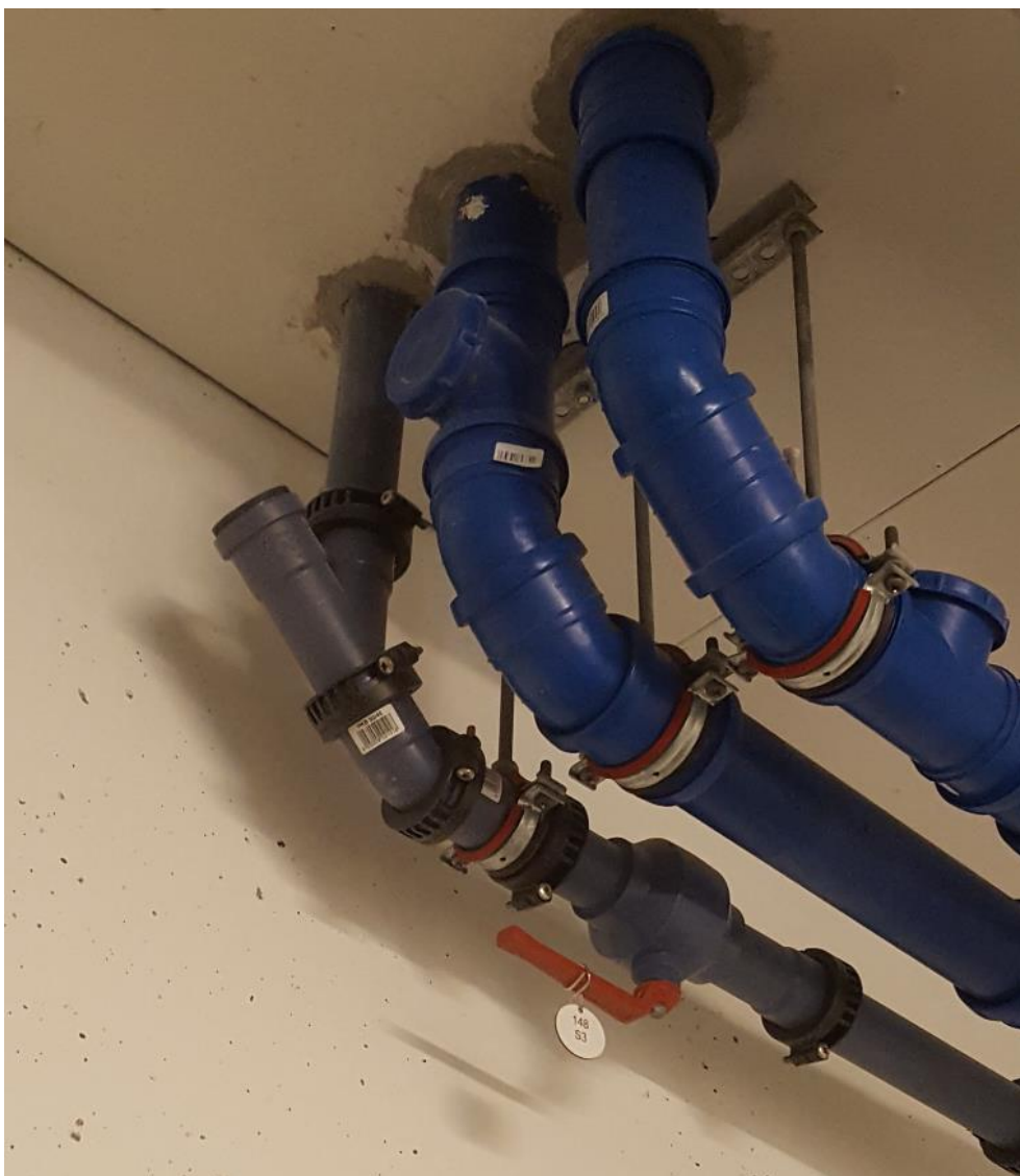
Figur 5 - Synliga och åtkomliga proppade ändar i rörsystemet bör vara säkrade.
